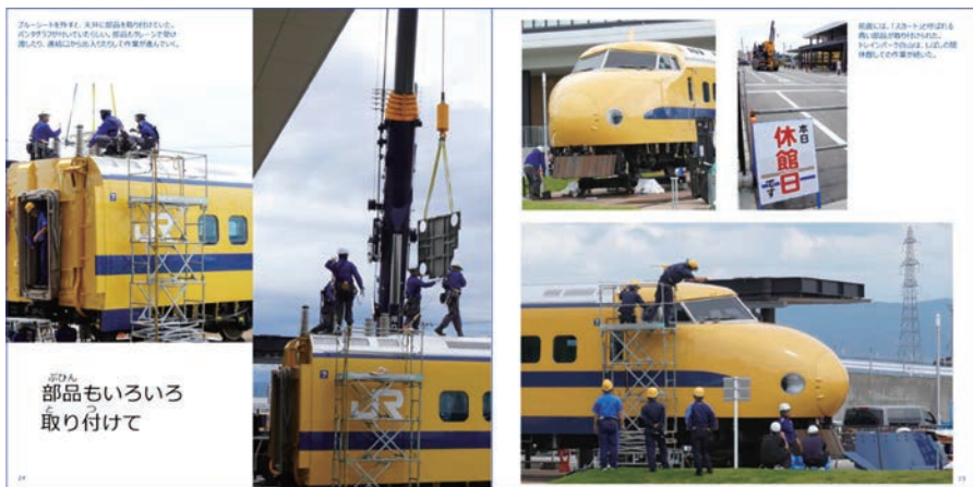
⑭天井部分にパンタグラフを取り付けている。 ⑮様々な作業が5日間の休館日の間に行われた。
